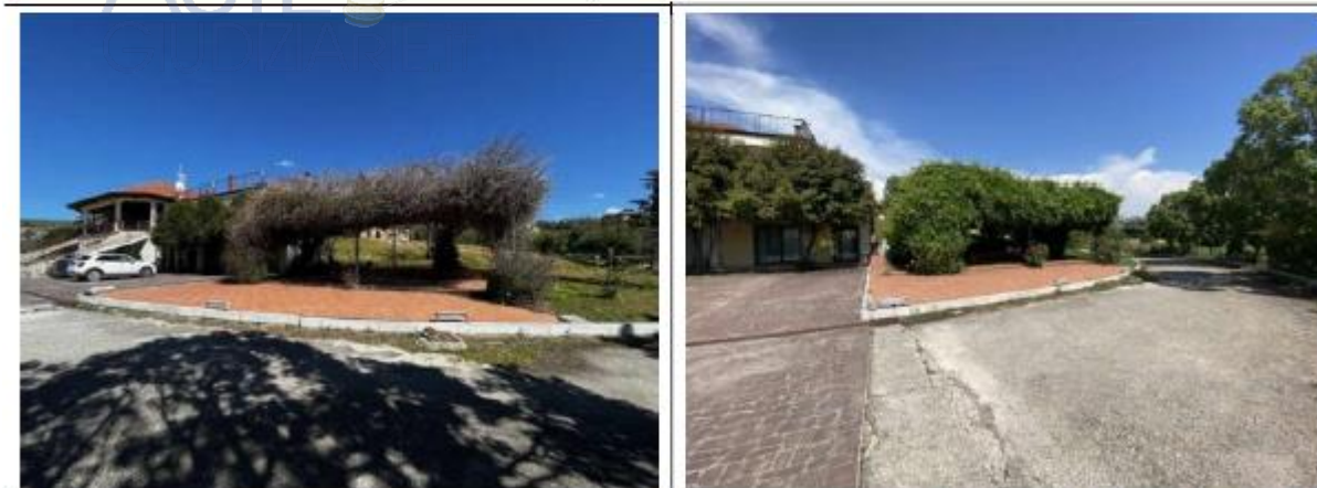
FOTO 162-163: Dettagli degli spazi pavimentati e con presenza di piante ornamentali e posti auto maggiormente prossimi al manufatto della struttura ricettiva.
