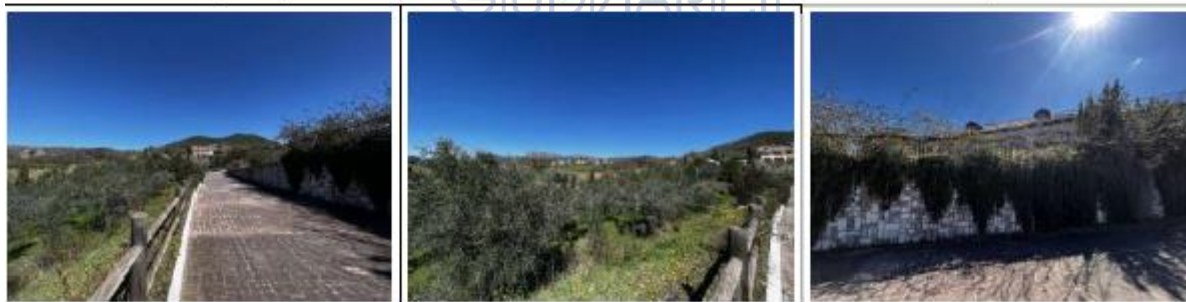
FOTO 158-160: dettagli delle porzioni tenuti a viabilità da via degli Agrumi, ad Uiveti con sottofondo erboso meritevole di interventi di pulitura e della recinzione murata che separa il complesso dagli ulteriori terreni agricoli di Proprietà Terza e non alienati nei passaggi di proprietà.
