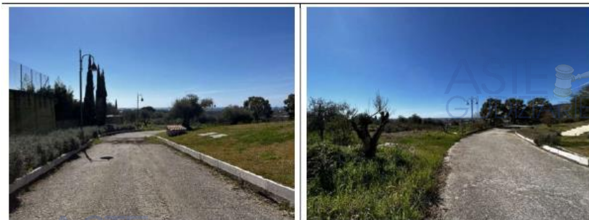
FOTO 160-161: La viabilità a servizio dei terreni agricoli segue un andamento ellittico su tutto il versante sud del Lotto.
